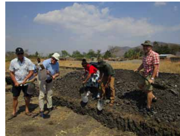
Bild.5 En ny skola skall byggas i Linthipe. Här tas första spadtaget!
